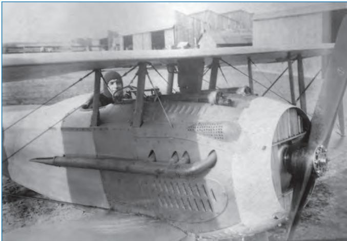
Une hélice Éclair montée sur le Spad XIII à capot blanc du MdL Georges Paumier de la Spa 155, en février-mars 1918 (Coll. Bentresque via Cony)
