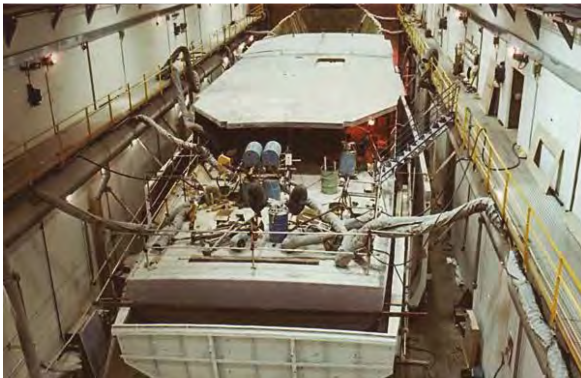
La coque du Pégase en construction dans une alvéole de Kéroman. (DR).
