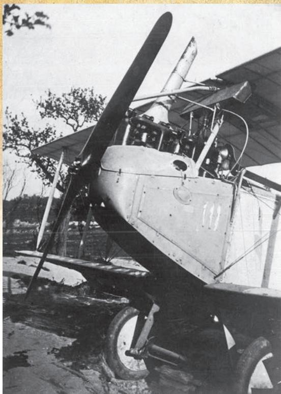
Cette vue de détail de l'appareil montre qu'il est équipé d'un moteur Mercedes D.III 160 HP, contrairement à d'autres machines du même type propulsées par un Benz Bz.III de seulement 150 HP.
