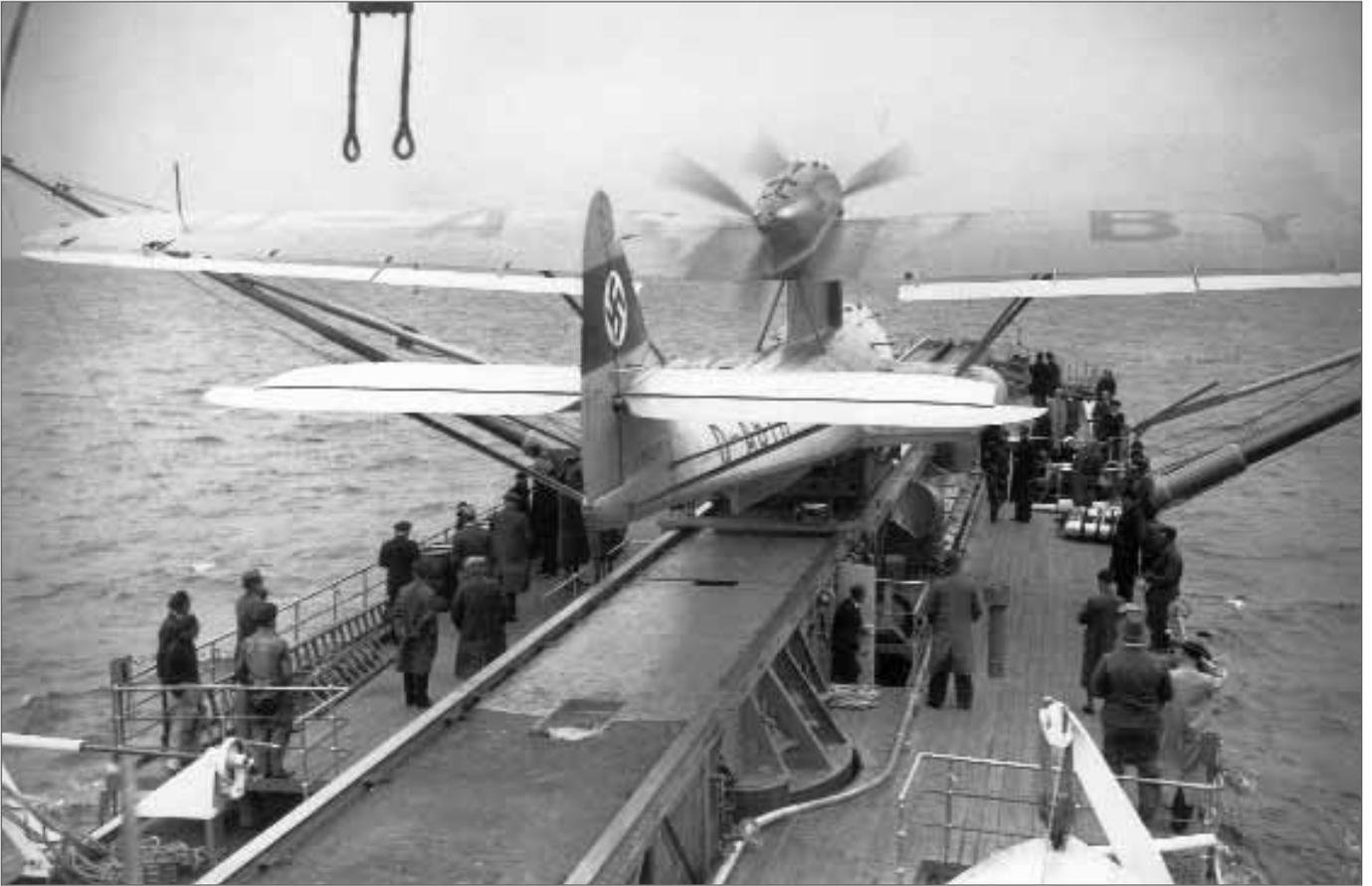
Deux vues prises à bord du navire à catapulte *Ostmark* de la Lufthansa et montrant le catapultage, en 1937, du Do 18 V3 D-ABYM *Aeolus*. La catapulte de 15 tonnes de poussée était fabriquée par Heinkel.
