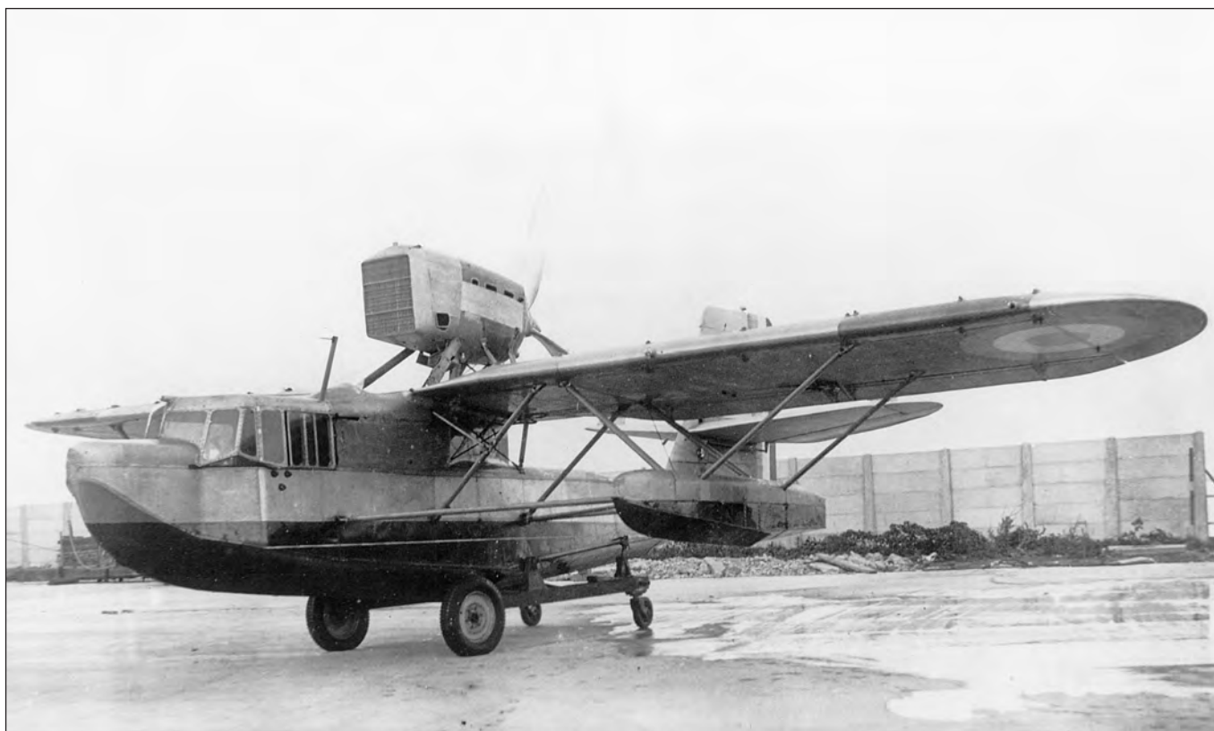
Vue de trois quarts avant du prototype à Saint-Nazaire, à la fin de 1934. La tourelle arrière n'est pas encore montée. On remarque le radiateur d'origine et l'emplacement du mât supportant la prise d'air du badin. Le radiateur d'huile est à peine visible, sous le fuseau moteur ; il fut plus tard installé, plus en avant, sous le radiateur d'eau. (Collection Pierre Cortet)
