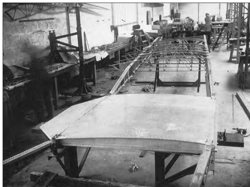
Construction de la voilure, à structure entièrement métallique. On remarque l'emplacement laissé libre pour les réservoirs, de part et d'autre du plan central. (Archives Pierre Leyvastre via Jacques Moulin)
