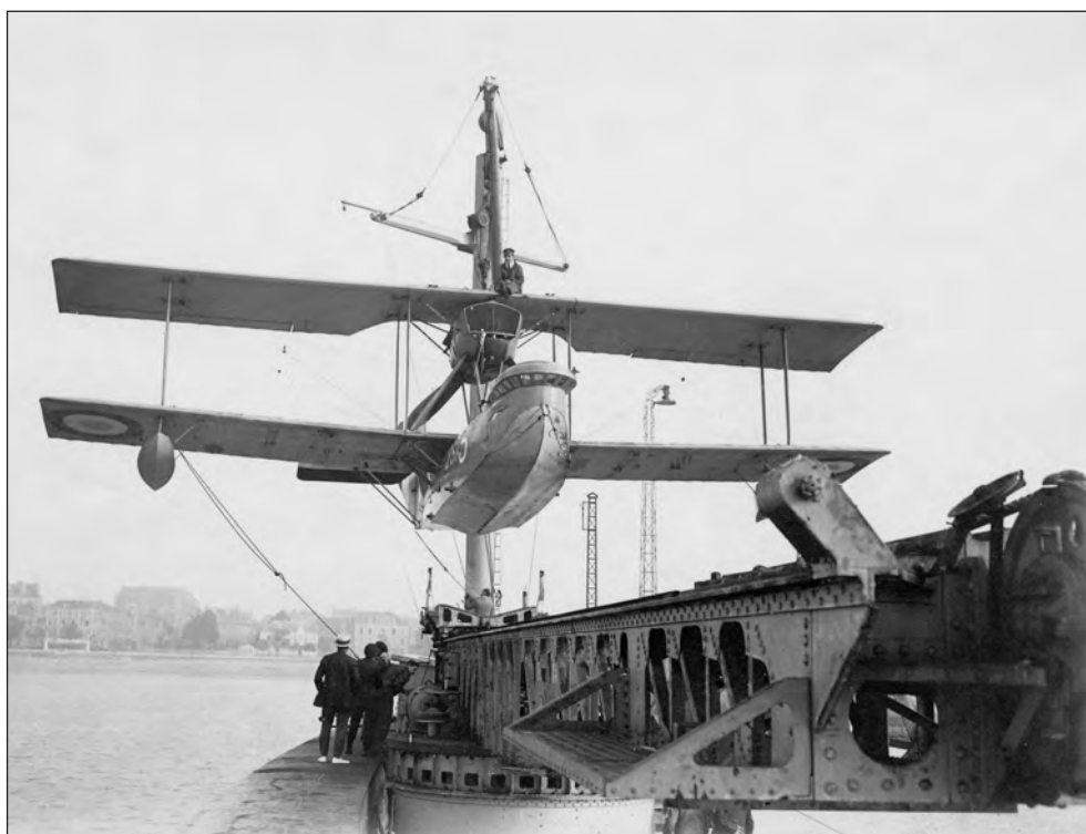
L'hydravion à coque CAMS 37A (ici le 2S1-5) fut également essayé sur une catapulte de 3000 kg. Ces tests, bien que menés par la Marine, étaient destinés à vérifier la possibilité de l'utilisation de ce type d'hydravion à partir de la catapulte montée sur le paquebot transatlantique Île-de-France . (Collection Michel Ledet)
