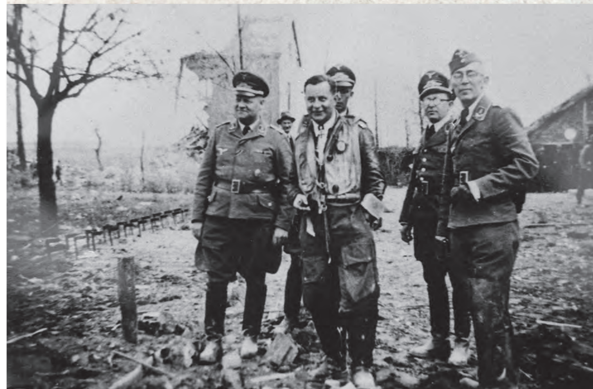
Le Major Prüller vient inventorier les dommages à Wevelgem.
