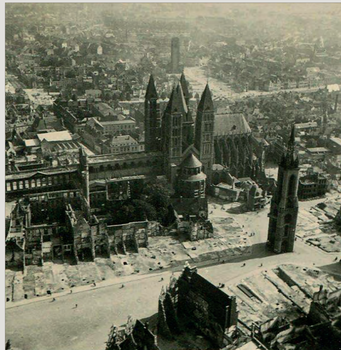
Vue aérienne prise pendant la guerre des importantes destructions de Tournai. Les ruines ont été complètement déblayées.
