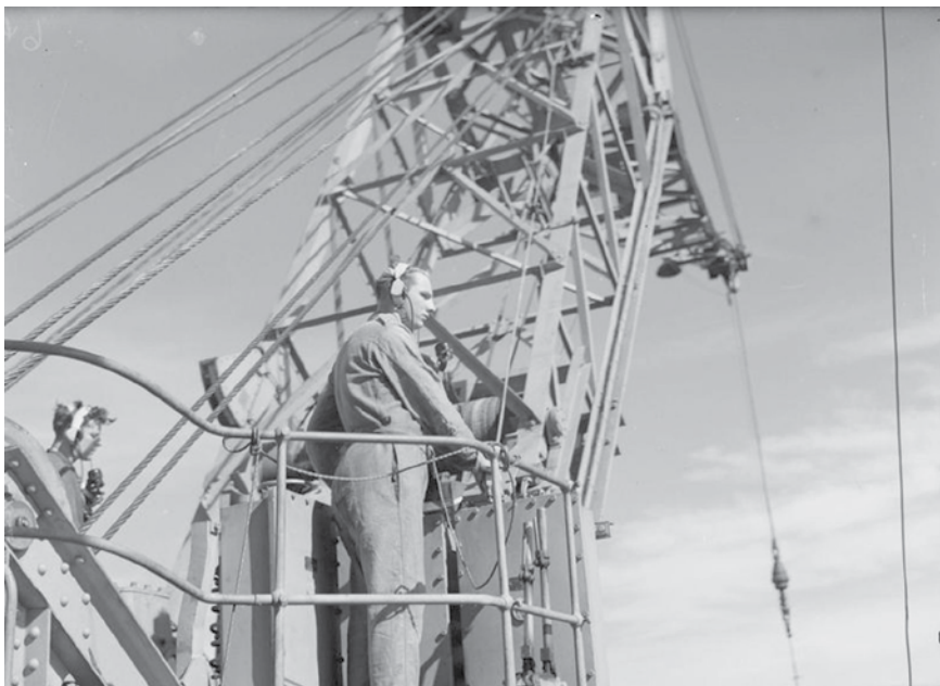
A la commande d'une grue de manutention du Howe.
