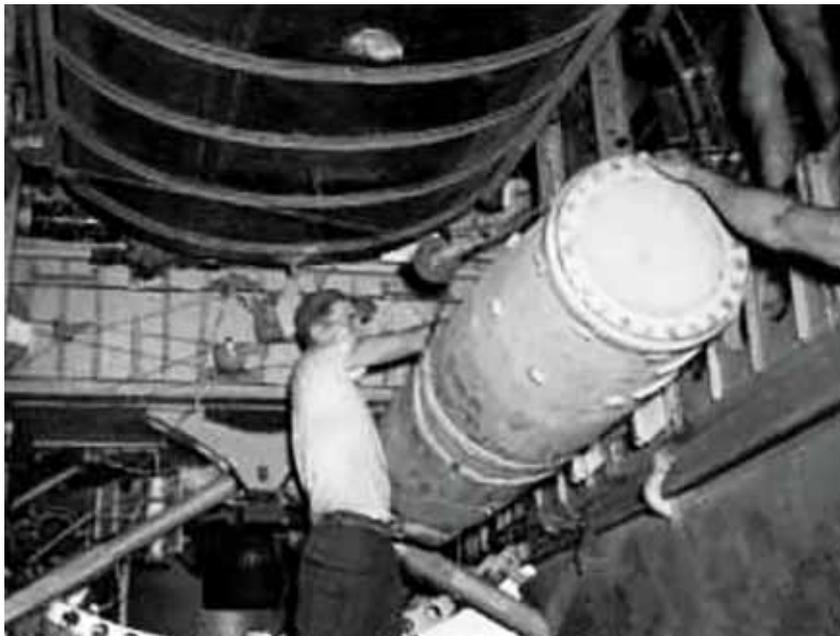
Des armuriers installent une mine Mk. 25 dans une soute de B-29. On note (au-dessus) l'énorme réservoir de soute qui augmentait l'autonomie de l'avion mais réduisait sa charge offensive. (USAF)
