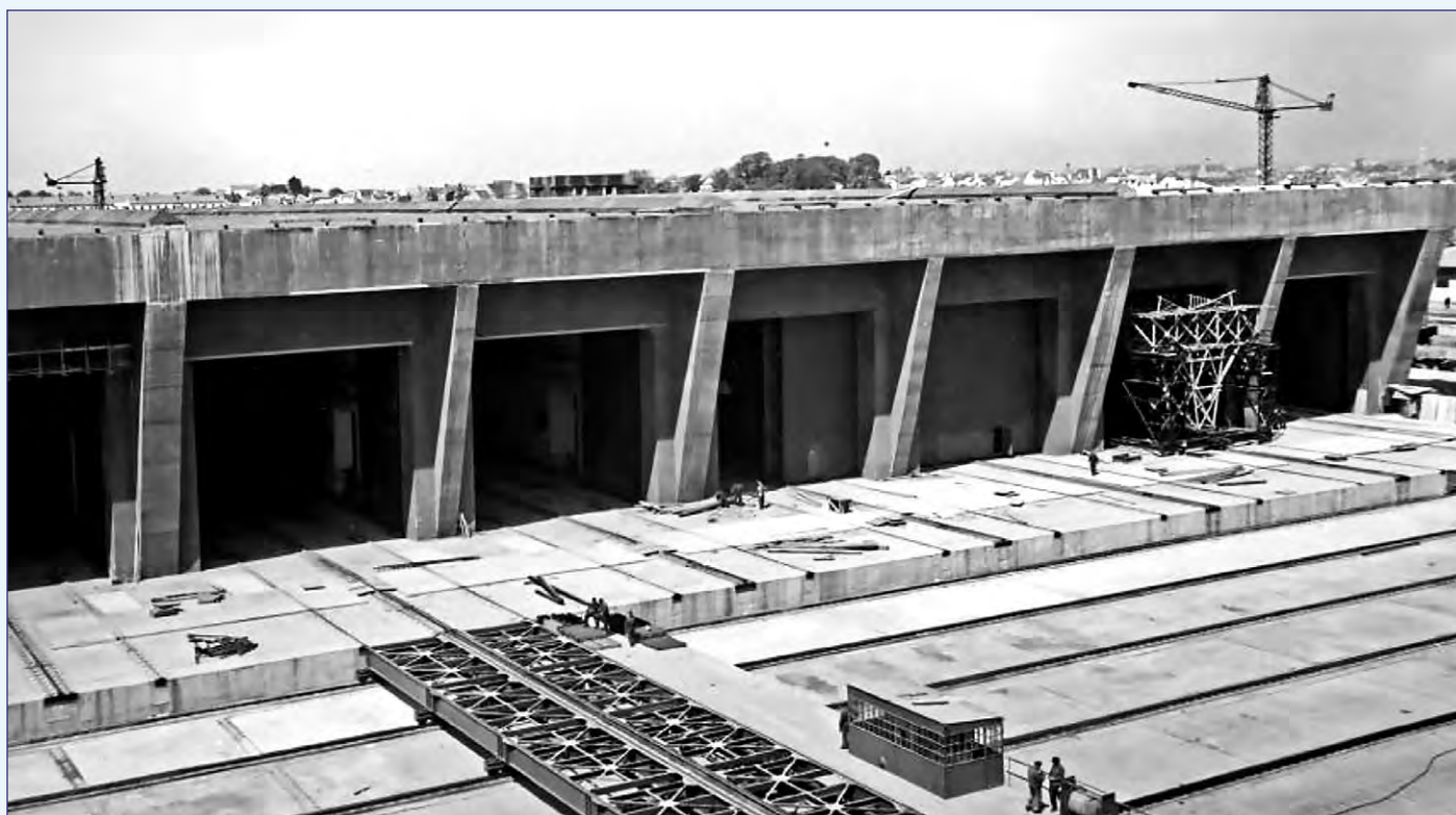
Séparé par un plateau de translation en plein air de 87 m, Keroman II est construit en vis-à-vis de Keroman I. (Site Spiegel)
