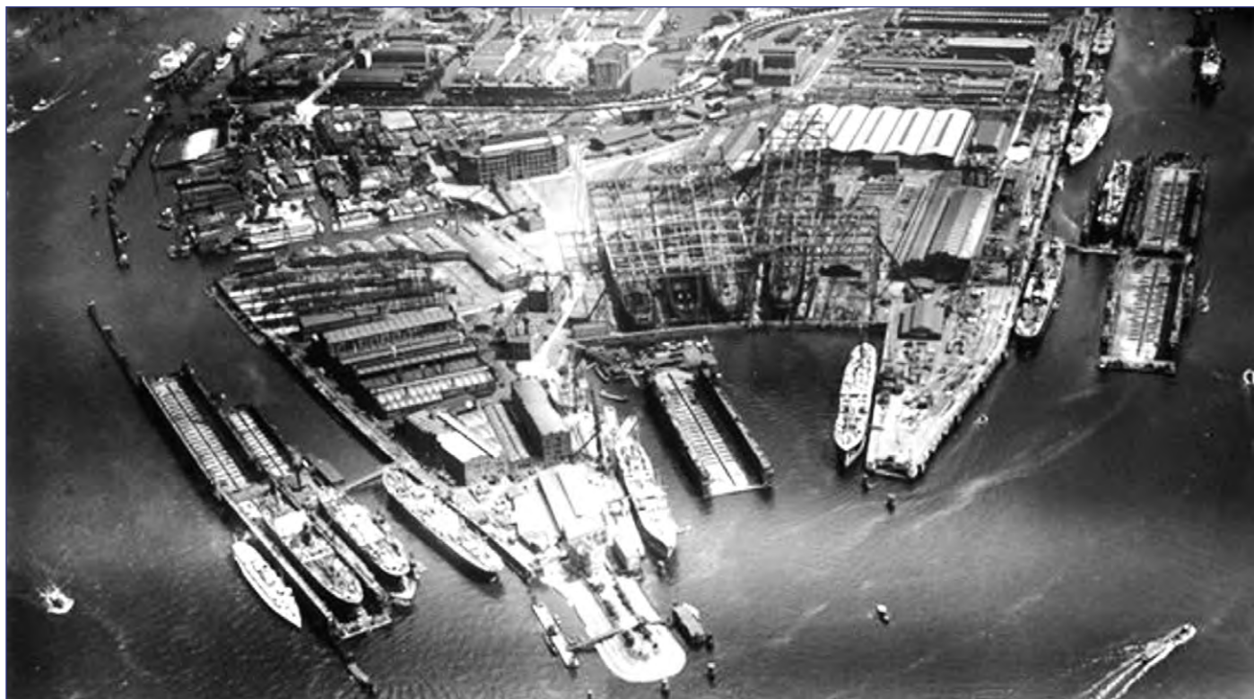
Le chantier Blohm & Voss à Hambourg. (Photo Alliance/akg-images)
