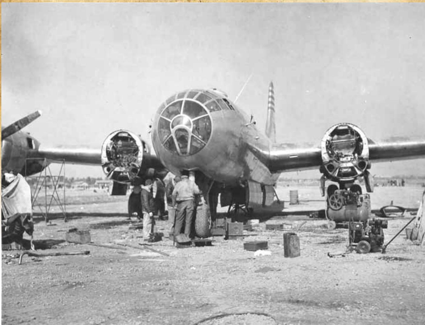
Le moteur Wright R-3350-23A, bête noire des équipages du *XX Bomber Command*. Sur le plan de la mécanique, une indéniable amélioration fut constatée au cours du dernier trimestre de 1944 avec l'arrivée de B-29 de seconde génération grâce auxquels un remplacement des appareils anciens et toujours sujets à problèmes put s'opérer progressivement. (NARA)
