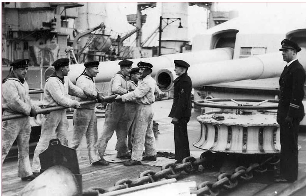
Entretien des pièces de 280 mm à bord de l' Admiral Graf Spee .
