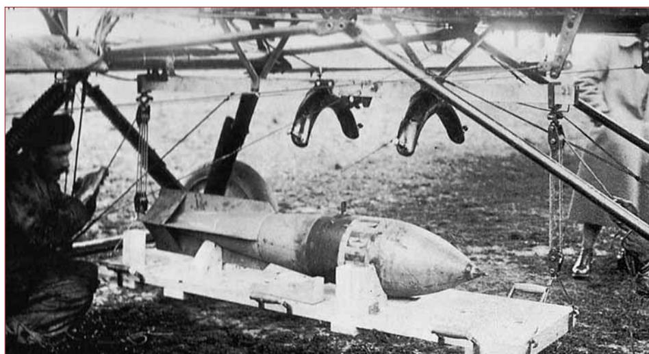
Mise en place d'une bombe de 500 kg sous un Voisin X (limité en principe à 300 kg). Amené sur un brancard positionné par 6 soldats, le projectile est hissé par deux mouffes. (P. Lissarague)
