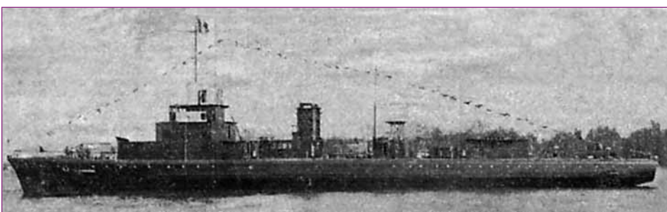
La Capricieuse flotte maintenant sur la Loire, puis sera remorquée jusqu'à son quai d'armement où les travaux continueront jusqu'à son achèvement.
