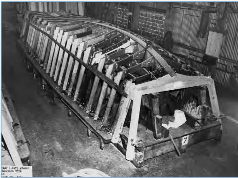
Vue d'usine d'un LCVP en construction, la structure avec couples en bois est bien visible.
