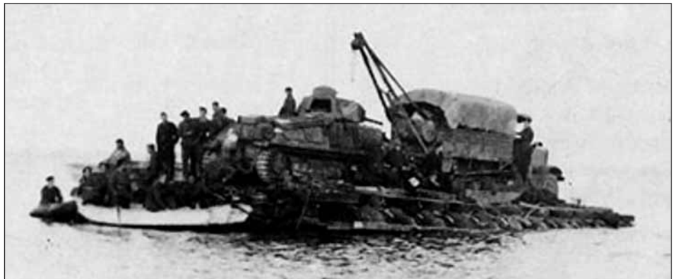
Un char Somua S 35 et un camion Dodge ont pris place sur l'une des plateformes construites par le Génie. (DR)
