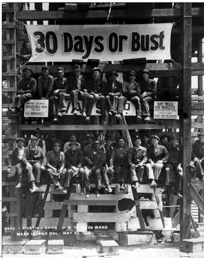
L'équipe d'ouvriers qui réalisera le tour de force d'assembler l'USS Ward en un temps record.
