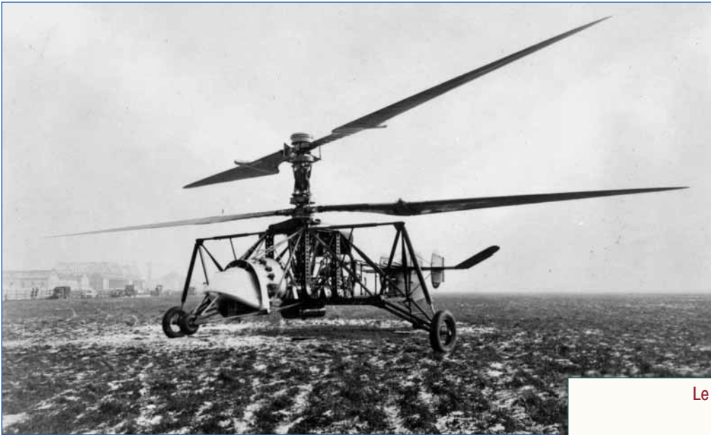
Le Gyroplane Laboratoire configuration finale, avec le moteur Hispano. (MC 27380 © MAE)
